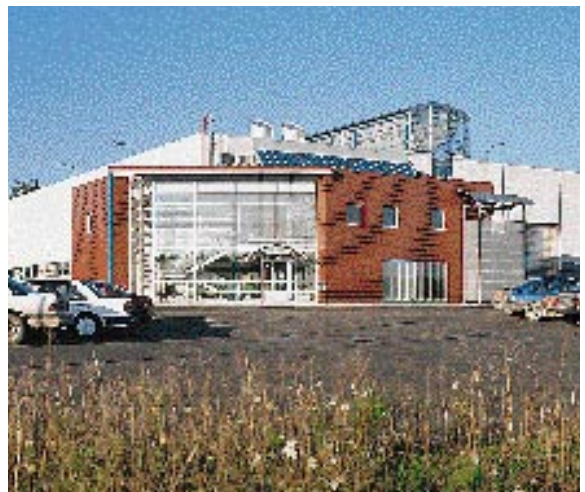
Ceiko Oy:n rakennuttama konepajahalli toimisto- ja sosiaalitiloineen on tilavuudeltaan 29.189 m 3 .
