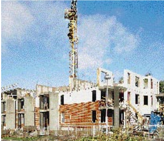
Vatro Oy:lle Helsingin Vuosaaren rakennettavan Leikosaarentie 12:n rakennustyöt käynnistyivät keväällä -94. Rakennuksen tilavuus on 37.000 m 3 ja asuntoja siihen tulee 110.
