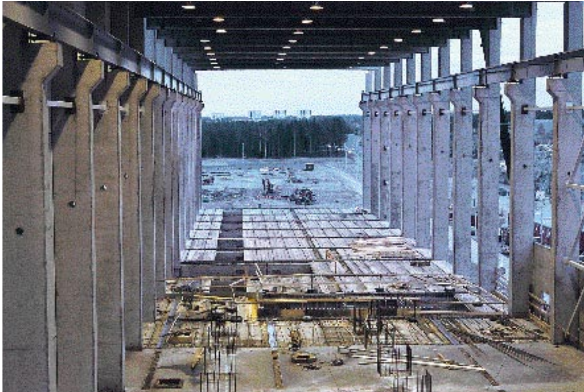
Oy Metsä-Rauma Ab:n Rauman sellutehdas on Suomen suurin rakennustyömaa. Hartela Oy on mukana rakentamassa massatehdasta, voimalaitosta ja käyttökotkia.
