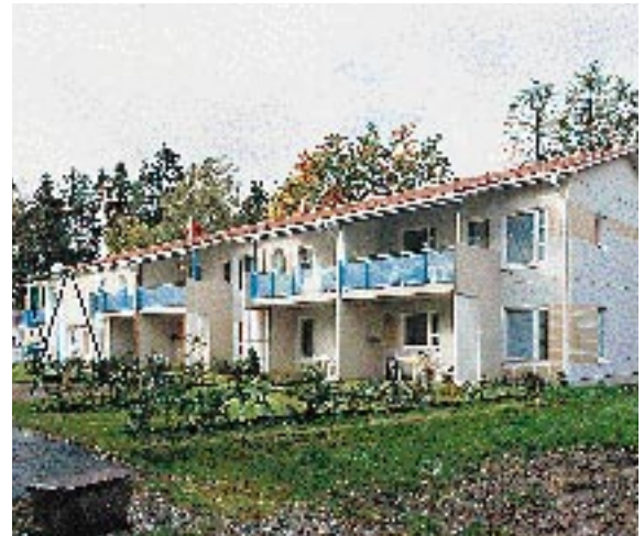
Salpa-asumisoikeus Oy:lle KVR-urakkana Espoon Leppävaaraan rakennettu 18 asunnon Kiinteistö Oy Peukaloisenpolku valmistui kesällä -94.
