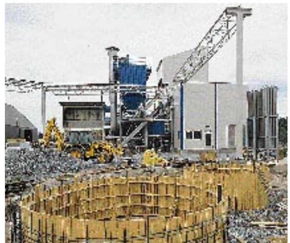
Kemira Pigments Oy:n Porin ferrisulfaattilaitoksen valmistuminen aloitushetkestä asennusvalmiiksi kesti vain 2 kk.
