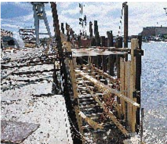
Näyttönä vaativasta erikoisrakentamisesta on Finnyardsin telakan uusi varustelulaituri 4, jonka pituus on 170 m ja syvyys 10 m. Urakka sisälsi mm. vedenalaisia Contractors-menetelmällä tehtyjä betonivalutöitä.
