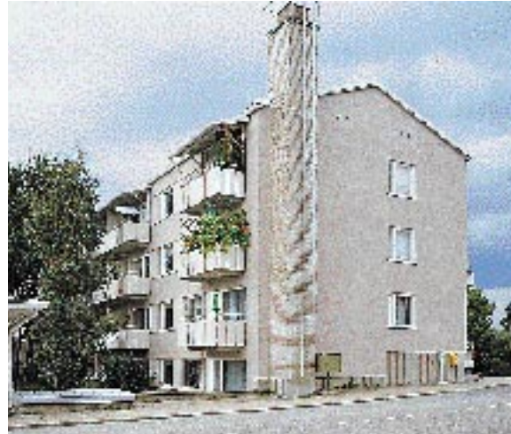
Kiint. Oy Vasaraharju on osana ympäristöministeriön REMONTTI-ohjelmaa "Toistuva tilakorjaus -menetelmällä toteutettu 58 asunnon korjausrakentamisen kokeiluprojekti.
