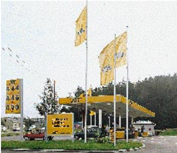
Hartela on rakentanut yhteensä 9 JET-asemaa Du Pont JET Oy:lle. Asemat rakennettiin tehokkaasti 6 viikossa, mm. Poriin, Raumalle, Turkuun ja Hyvinkäälle.
