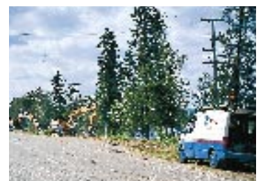
Vuonna 1994 asennettiin 2 500 kaapelikilometriä. Vuoden lopussa valokaapeleita oli asennettu 13 000 km, joissa on 160 000 kuitukilometriä.
