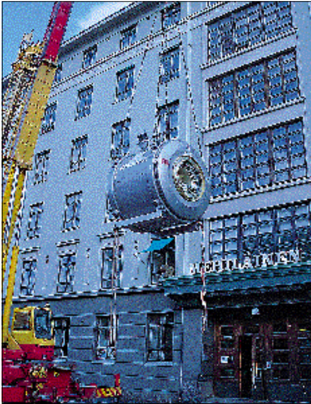
Christian Nissen -osasto toimitti Mehiläisen sairaalan röntgenosastolle huippuvarustellun korkeakenttä-magneetin Picker Edge 1.5 T. Nosturissa roikkuva magneetti nostettiin kuudenteen kerrokseen kätevästi sisään kattoon tehdyn reijän kautta. Laitteen paino n. 7000 kg.
