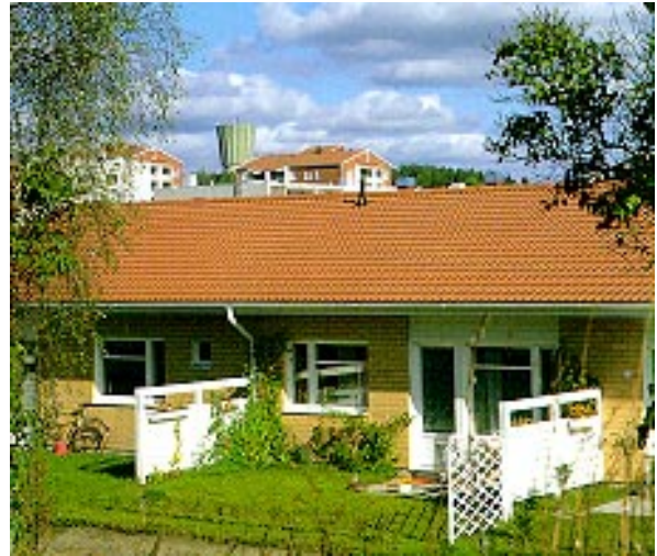
ASO Olavintytär on 16 asunnon asumisoikeuskohde Kaarinassa, tilavuus 4.860 m 3 . Rakennuttajana YH-Rakennuttajat.
