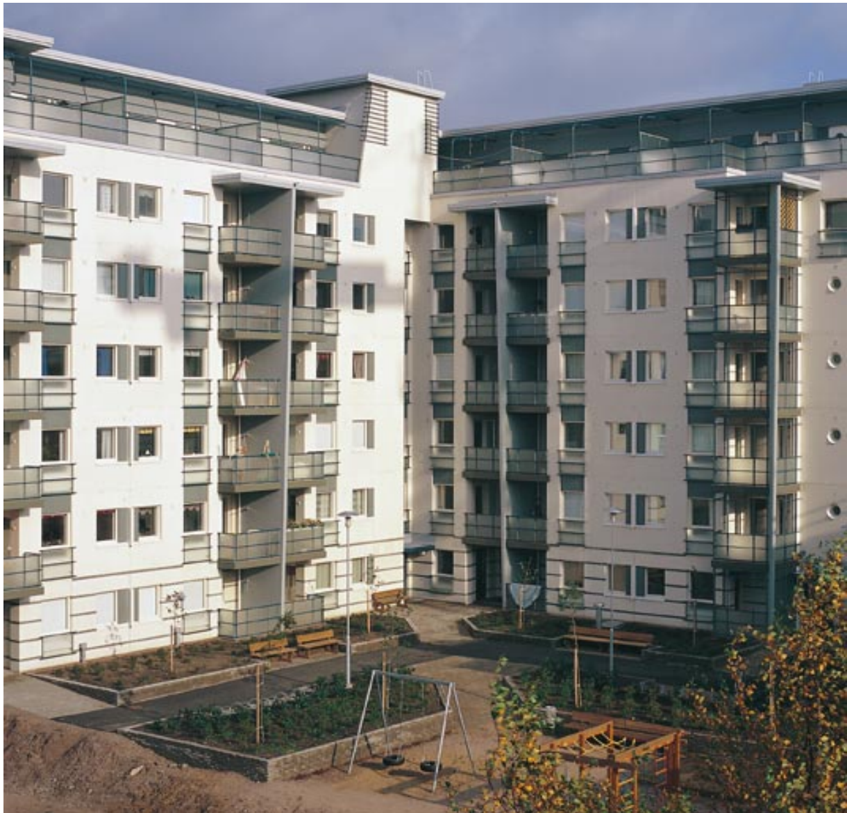
Helsingin Ruoholahteen valmistui keväällä 1995 Merimieseläkekassalle rakennettu Asunto Oy Helsingin Seilori, jossa on 50 asuntoa.
