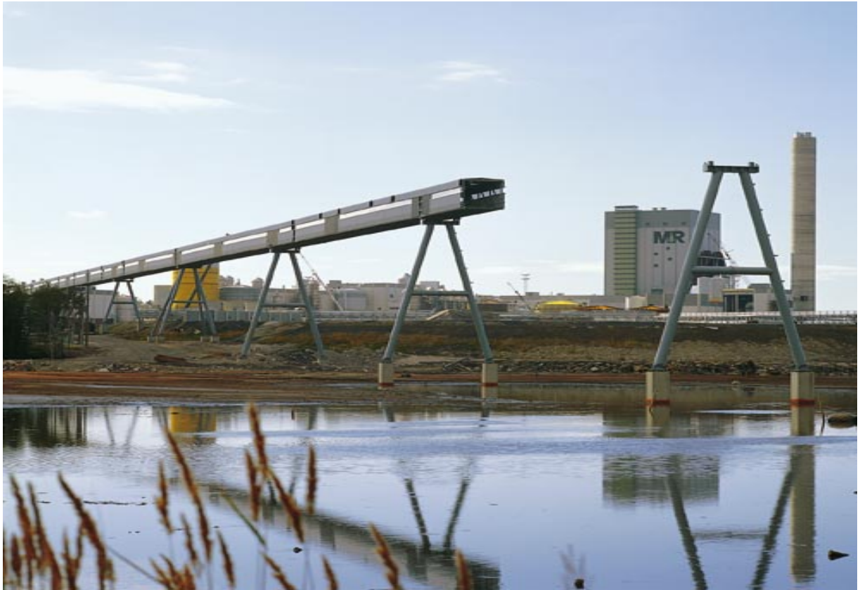
Taustalla näkyvän Metsä-Rauman sellutehtaan rakentamisessa Rauman Hartela on ollut vahvasti mukana mm. valaen 25.000 m 3 paikallavalurakenteita. Etualalla näkyvä YPT:n rakennuttama kuljetin kuljettaa sellun paperitehtaalle. Kuljettimen vedenalaiset perusrakenteet kuuluivat Hartelan urakkaan. Perustukset toteutettiin kasuuniteknikalla ja perustettiin 610 mm teräspaalujen varaan syvimmillään 25 metrin syvyyteen.
