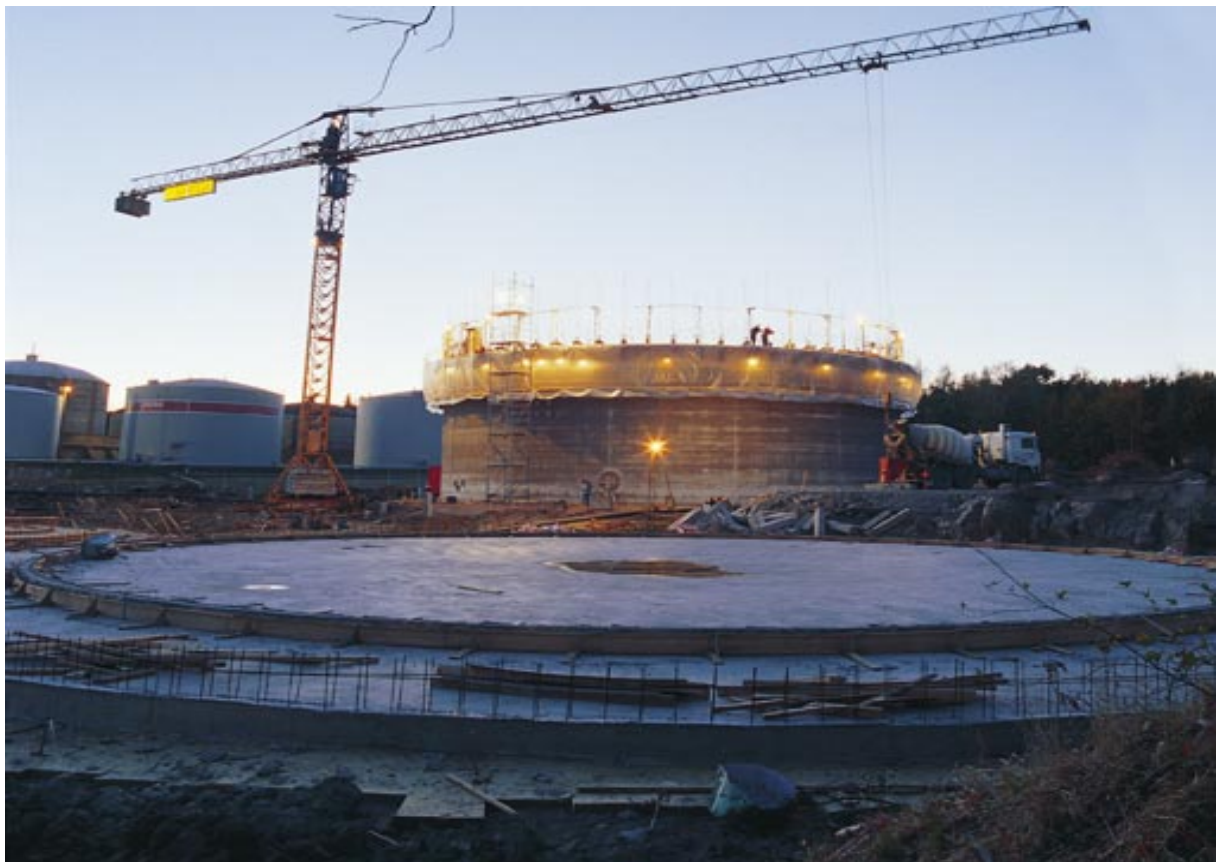
Kesällä 1995 allekirjoitettiin Du Pont JET Oy:n kanssa Pansion bensiinin tuontivaraston urakkasopimus. Hartelan toimitukseen rakentamisen ja rakennesuunnittelun lisäksi kuuluvat putkisto-, sähkö- ja säiliötyöt. JET-asemia valmistui päätyneenä tilikautena Helsinkiin ja Hyvinkäälle ja kuluvana tilikautena valmistuvat Seinäjoen, Vaasan ja Helsingin asemat.
