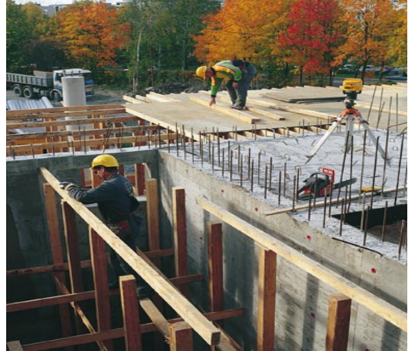
Turun kirurgisen sairaalan laajennusosan runkotyö käynnissä. Laajennuksen tilavuus on 48.697 m 3 .
