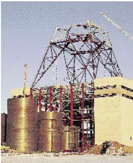
Pietarin suurvoimalaitoksen rakentaminen käynnistyi vuoden 1995 alussa.
