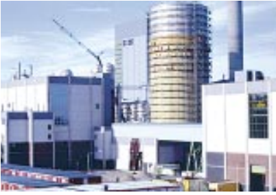
Parocin teknisten eristeiden vuoden 1995 suurin toimitus tehtiin Metsä-Rauman uuteen selluloosatehtaaseen. Tehtaaseen toimitettiin yli 10 000 m 3 eli yli sata rekka-autollista levy-, matto ja kourueristeitä. Käyrien putkien eristäminen nopeutui Lappeenrannan tehtaan uutuustuotteiden, esivalmistettujen eristesegmenttien ansiosta.
