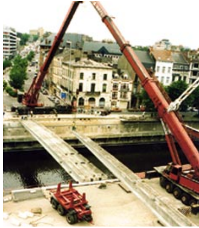
Infrastruktuurirakentaminen eli sillat, tunnelit ja ratapölyt muodostavat merkittävän osan Partekin betonielementtituotannosta. Kuvassa Partekin Belgian tytäryhtiön valmistamia Pont de la Résistance -sillan palkkeja asennetaan paikalleen Charleroin kaupungissa Belgiassa.
