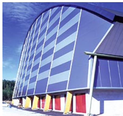
Kevyet, mutta kantavat ja paloturvalliset PAROC-rakennuselementit sopivat niin teollisuushallien, julkisten rakennusten kuin urheilutilojenkin rakentamiseen. Paroc on toimittanut mm. Norjaan useiden jalkapallohallien julkisivut. Kuvan halli sijaitsee Oslon lähellä Bön kunnassa.
