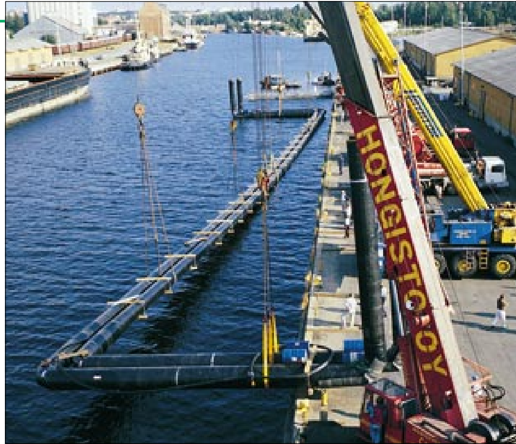
Kaukolämpöverkosto syntyy Rautaruukin virtausputkista myös veden alle.
