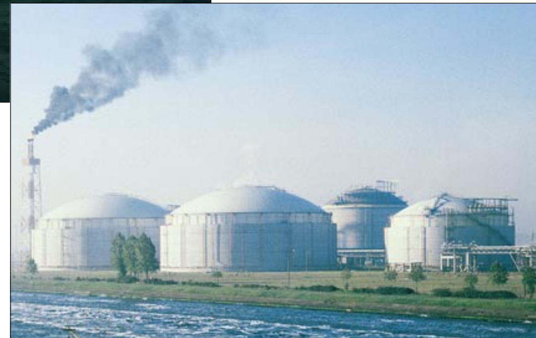
Atwerpenin satamassa olevat polttoainesäiliöt on rakennettu Rautaruukin asennusvalmiista esikäsitellyistä teräslevyistä.
