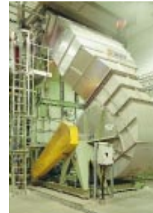
Aylesford Newsprint-yhtiölle toimitettu lämmöntalteenotto-laitteisto on olennainen osa paperitehtaan energiataloutta.
