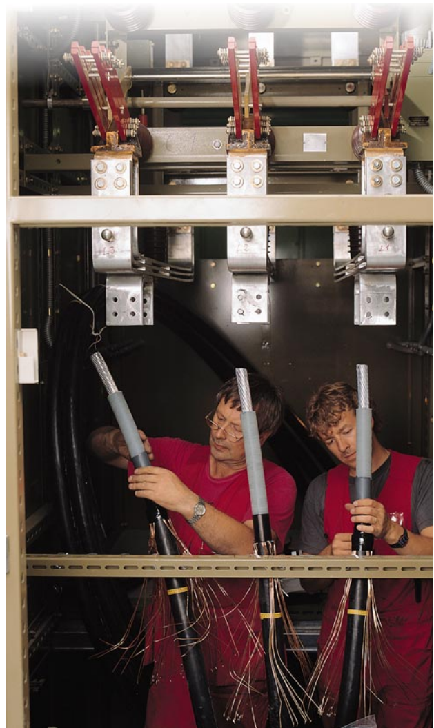
Jyrki Heinonen and Markku Laaja from ABB Installaatiot are installing a high voltage cable terminal.
