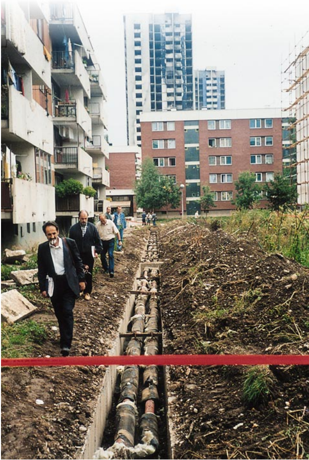
ABB Ecopipen elementtien avulla Sarajevossa liitettiin kesällä yli 30.000 kotitaloutta kaukolämmön piiriin.
