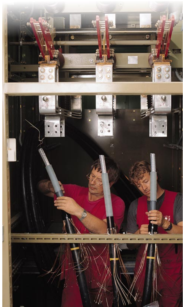
Jyrki Heinonen ja Markku Laaja ABB Installaatioista suurjännitekaapelipäätetyössä.
