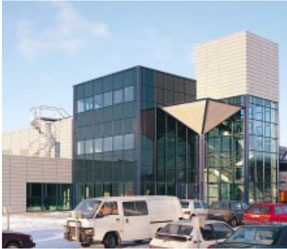
EMC-Testauslaboratorion rakennustyöt aloitettiin kesäkuussa 1996. Rakennuttajana on Telecom Finland Oy:n tytäryhtiö EMCEC Oy. Rakennuksen bruttoala on 2.947 m 2 ja tilavuus 17.100 m 3 .
