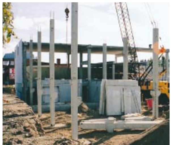
Wihuri Oy:lle Tampereelle KVR-urakkana toteutettavan Eurospar-mymmäen rakennustyöt käynnistyivät kesällä 1996. Rakennuksen tilavuus on 36.400 m 3 .
