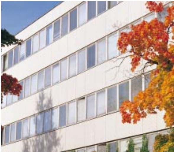
Turun yliopiston luonnontieteiden talo I ja Juslenian päätyjulkisivujen julkisivuelementit uusittiin ja rakennusten lämpöeristystä parannettiin. Uusi julkisivu tehtiin ulkonäöltään täysin alkuperäisen mukaiseksi. Rakennuttaja Valtion Kiinteistölaitos. Rakennuttamistehdät Engel. Laattapintaisia elementtejä asennettiin noin 2.300 m 2 .
