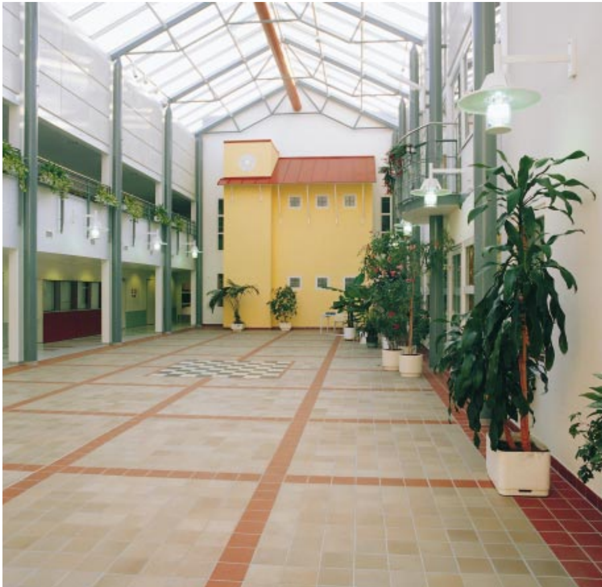
Vaisaaren yläasteen peruskorjaus ja lisärakennus (1-vaihe) on esimerkki erittäin nopeatempoisesta saneeraustyöstä, joka toteutettiin pääosin koulujen kesäloman aikana. Kuva sisäpihan tilalle tehdystä lasikatteellisesta juhlasalitulasta, "murkkumetsästä".
