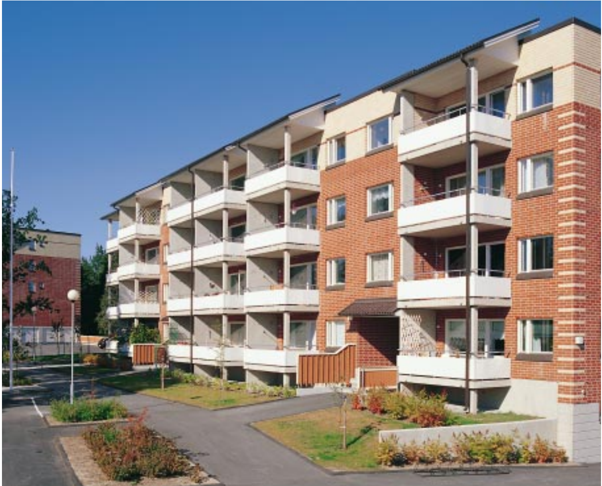
Espoon Leppävaaraan toteutettiin KVR-urakkana Henkivakuutusyhtiö Verdandille Asunto Oy Espoon Ruutikellarintie 9. Kohde valmistui tammikuussa 1996 ja tilavuus on 18.000 m 3 .
