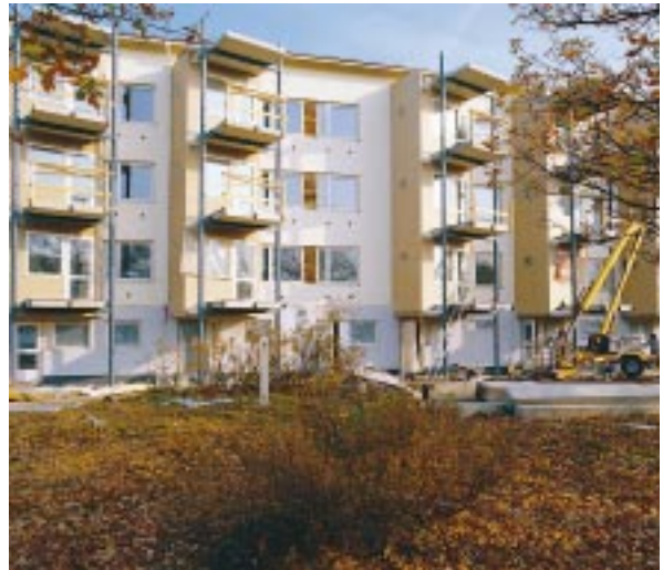
Vuoden 1997 asuromessuille valmistuu Neste Oy:lle täydellisesti peruskorjattu asuinkerrostalo. Vuonna 1956 valmistuneesta rakennuksesta jäivät jäljelle vain runko, huoneistojen väliset seinät ja vesikatto. Ranskalaiset parvekkeet korvattiin erkkeritomeilla, jolloin keittiöihin saatiin lisää tilaa ja julkisivuun ilmeikkyyttä. Kellarikerroksen tiloja, mm. autotallit muutettiin asuintiloiksi siten, että alakerran asunnoista tuli kaksikerroksisia. Tilavuus 9.700 m 3 , kerrosala 3.443 m 2 . Asuntoja 35 kpl.
