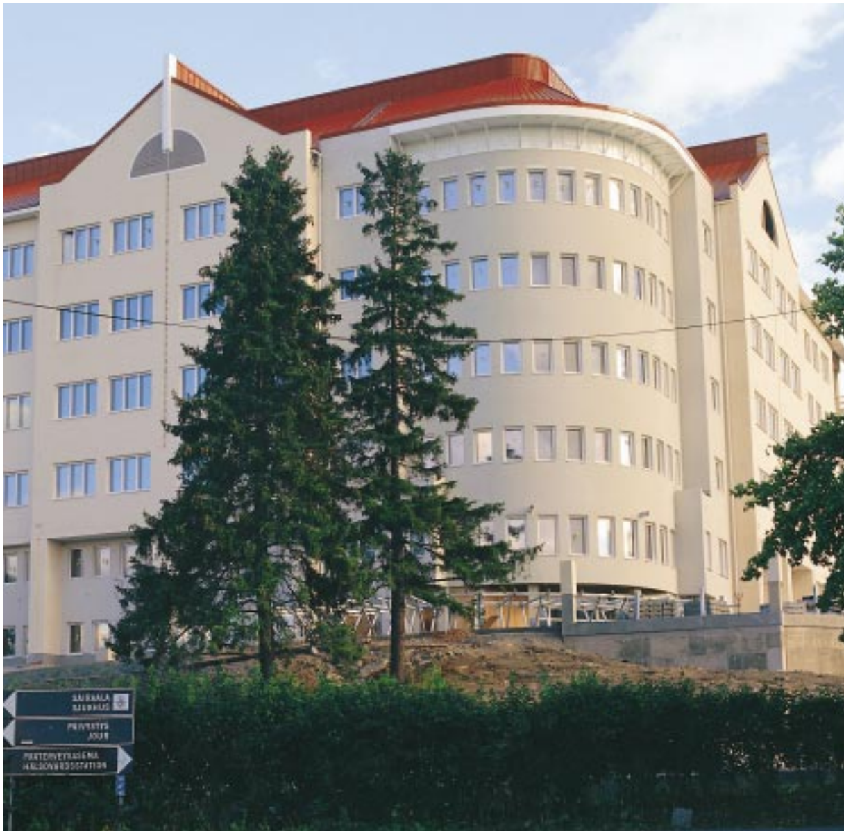
Turun kaupungin uusi kirurginen sairaala valmistuu maaliskuussa 1997. Rakennus on vaativa, runsaasti teknillisiä erikoisratkaisuja käsittävä kohde, jossa on käytetty viimeisintä sairaalatekniikkaa. Rakennuksen runko on tehty paikallavalutekniikalla. Julkisivut ovat paikallamuurattuja ja rapattuja. Sairaalan tilavuus on n. 49.000 m 3 ja bruttoala n. 11.200 m 2 .
