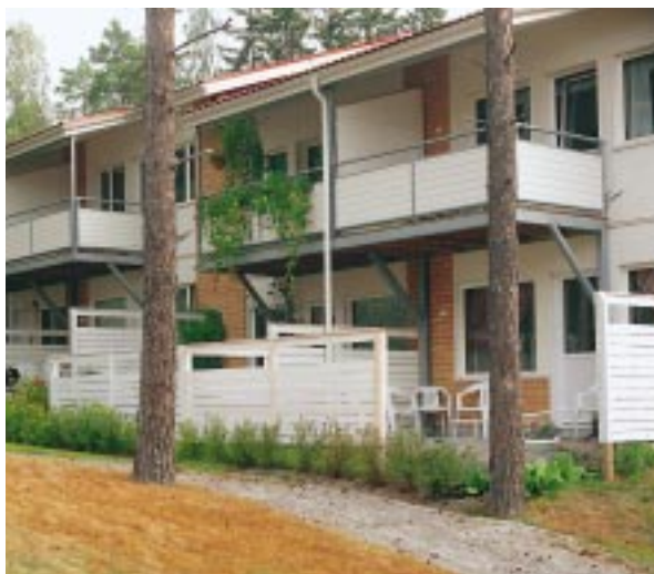
Tammistonpiika -niminen asumisoikeusyhtiö Naantalissa oli kysyntä- lähtöisen tuotantotavan koerakentamiskohde. Talot rakennettiin ensin runkovalmiiksi. Kaupan synnyttyä ja asukkaan valittua ennalta laadituista vaihtoehtoista mieltymystensä mukaiset tilajärjestelyt ja pintamateriaalit ns. solutyöryhmä rakensi asunnon kahdessa viikossa valmiiksi. Rakennuttaja TA-Asumisoikeus Oy. Tilavuus 3.760 m 3 , asuntoja 13 kpl.
