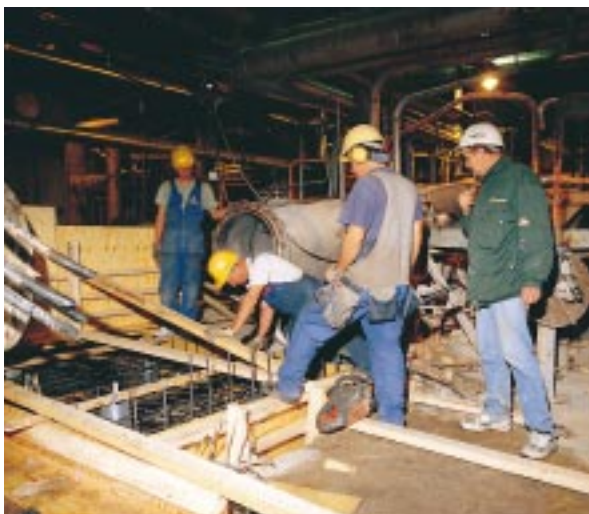
Hartela on Raumalla vakiinnuttanut asemansa vaativien teollisuuskohteiden saneeraajana. Tilikaudella toteutettiin UPM-Kymmene Oy:lle paperikoneen viiraosan uusinta seisokkityönä minuuttiaikataulua noudattaen.
