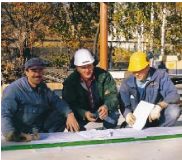
Rakennustöiden sujuminen ja laadukas lopputulos on yhteistyön tulosta.
