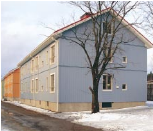
Edellisellä tilikaudella alkanut rakentaminen Tampereella jatkui. Hartelan ensimmäisenä kohteena valmistui TA-Asumisoikeus Oy:lle Metsäniitynkatu 17. Kuvassa Tampereen kaupungin tilakeskuksen Vuokratulosäätiölle rakennuttama VTS-Oikokatu 5, 7 ja 9. Kohde valmistui syksyllä 1996. Tilavuus 4.985 m 3 . Asuntoja 24.
