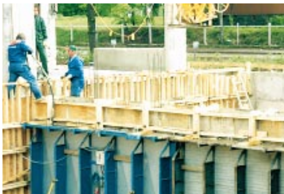
Laajennusosan perustusten tekoa toukokuussa.
