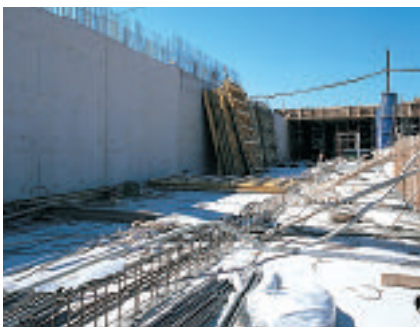
Insinöörirakennusyksikön metrotyömaa Helsingin Puotilassa.
