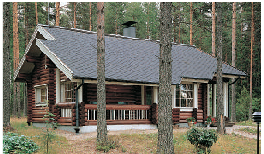
Lemminkäinen on maan johtava bitumisten kateaineiden valmistaja.
