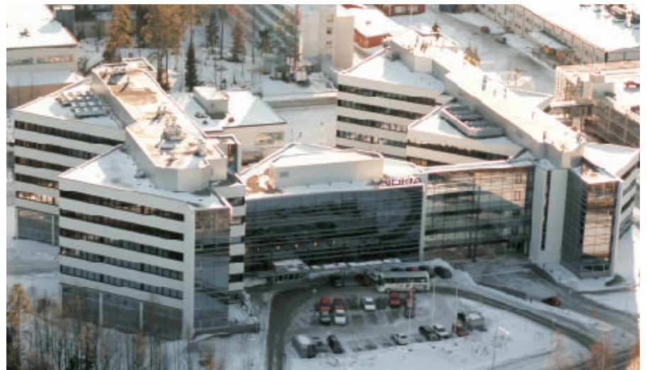
Nokia Oy:lle valmistui Espoossa projektinjohtourakkana tehty Telekara-tuotekehitysrakennus.
