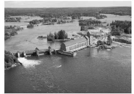
Äetsän voimalaitos valmistui kesällä 1996. Polarin Itä-Suomen yksikkö teki UPM-Kymmene Oy:lle Äetsän voimalaitoksen uuden koneaseman rakennus- tekniset työt.
