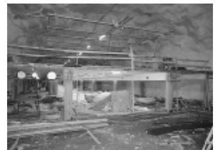
Kampin maanalaisten pysäköintitilojen laajennuksen lisäksi Polar rakentaa yhdystunnelin Forumin pysäköintihallin ja Sokos-tavaratalon välille.
