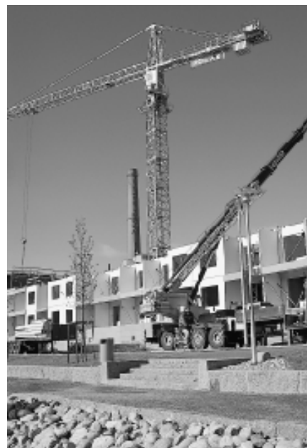
Polarin Länsi-Suomen yksikön Kuntien Eläkevakuutukselle rakentama Kiint.oy Turun Rosita ja Carolina Aurajoen rannalla Turussa. Kohteeseen tulee 119 asuntoa ja 129 autopaikkaa.
