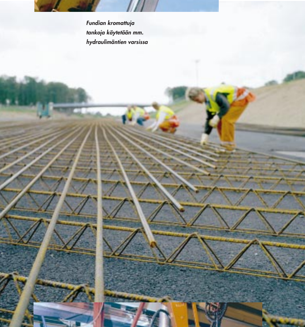
Fundian ja Ruotsin tielaitoksen yhteinen betoniteiden raudituskokeilu onnistui hyvin
