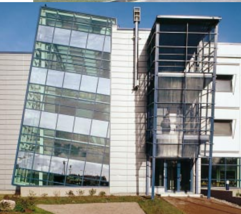
Teräksiset julkisivuelementit vahvistavat asemaansa liikerakentamisessa. Nokian uusi matkapuhelin-tehdas Oulussa
