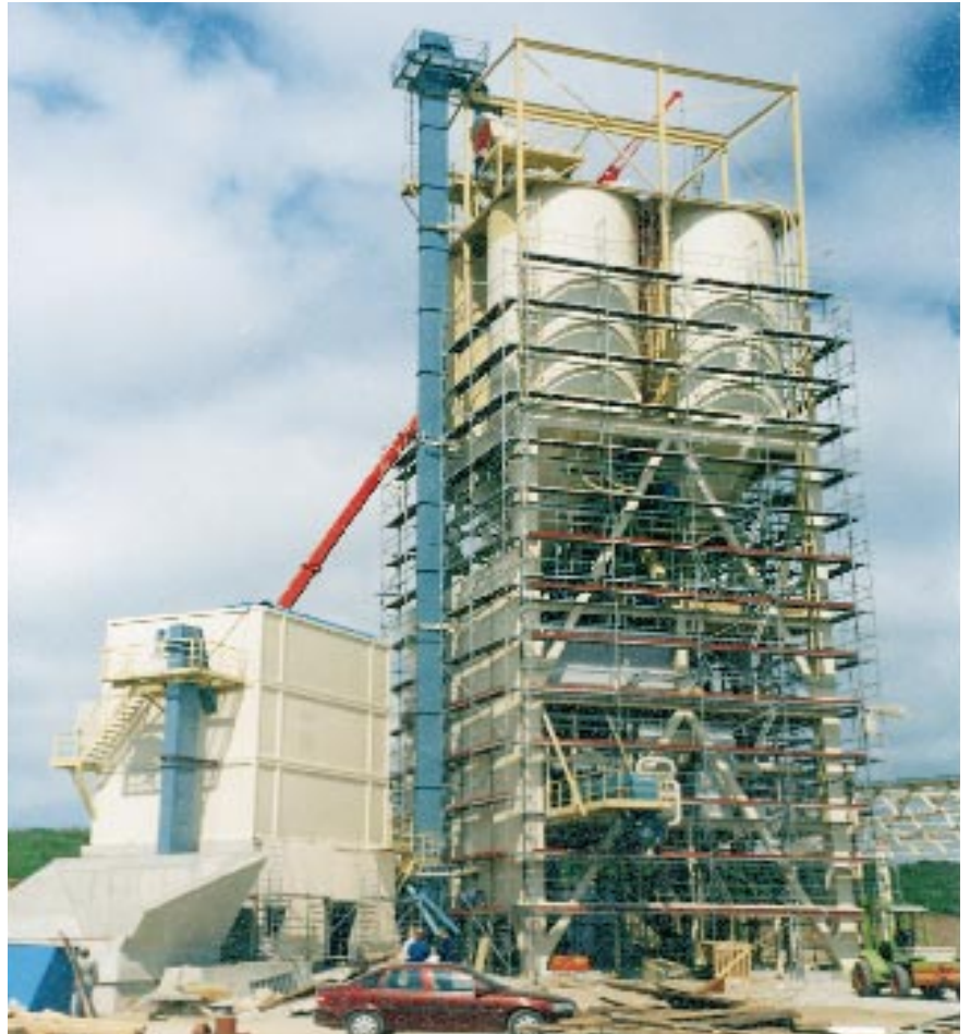
Raute Dry Mix Oy:n mittavin projekti vuoden 1996 aikana oli laasti- ja tasoitetehtaan toimitus Rethwisch Baustoffwerkille Saksaan. Kuvassa tehdas rakennusvaiheessa.
