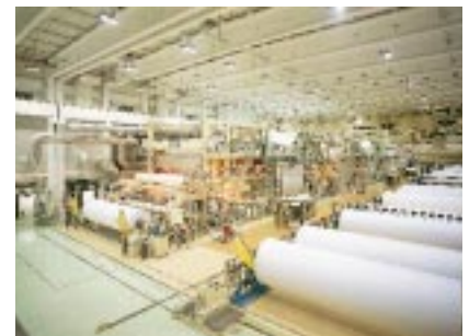
Neljällä AutoBlade -päällystys- asemalla varustettu off-machine -päällystyskone UPM-Kymmene -konsernin Nordland Papierin tehtaalla taidepainopaperia valmistavalla linjalla Saksassa.
