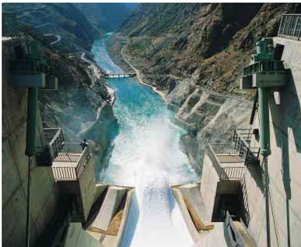
Karakayan vesivoimalaitos Turkissa. EWE vastasi laitoksen suunnittelusta sekä rakentamisen valvonnasta ja koordinoinnista.
