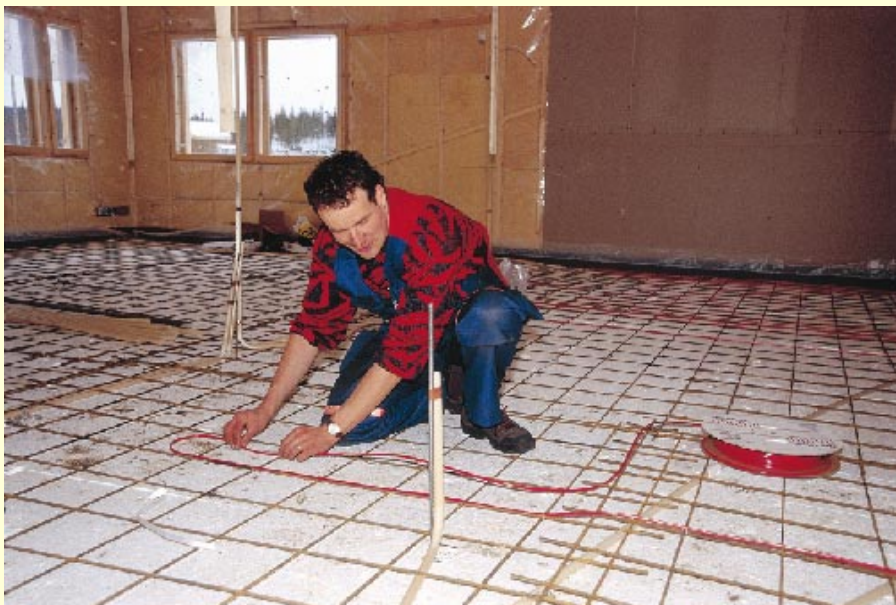
Petäjävedellä tehtiin omakotitalojen sähköasennuksia.
