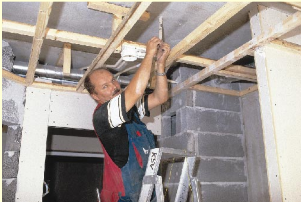
Metsärinteentie 2:een Jyväskylän maalaiskunnassa rakennettiin pienkerrostalo, jonka sähkötyöt urakoi Keski-Suomen Valo.
