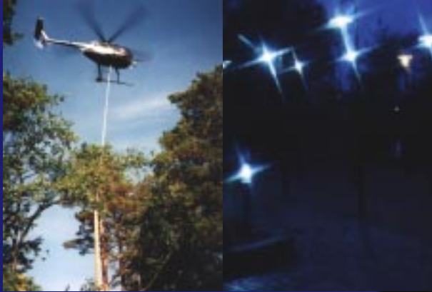
20 kV:n merikaapelin lasku välillä Pitkäsaari Karhusaari. Samalla laskettiin myös Kymen Puhelin Oy:n puhelinkaapelit. Pylväät lennätettiin Kotkansaarelta Pitkäsaareen helikopterilla.
