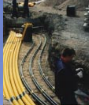
Voimalaitoksen generaattori- ja ohjauskaapelointia kesällä -97.
