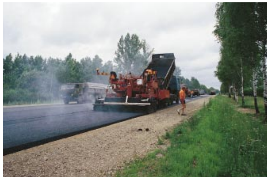
Päällystystyö käynnissä Moskovan-Minskin valtatiellä.
