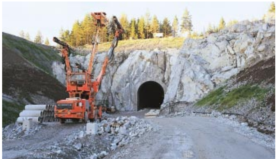
Ruotsin pisintä rautatietunnelia rakennettiin Norralla.
