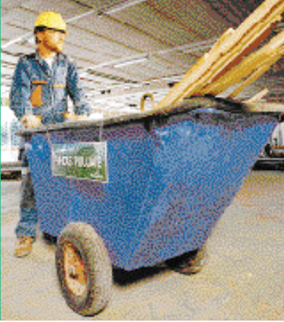
Jätteiden määrää vähennetään. Mikäli kyetään, uusiokäytetään tai hyödynnetään energiana. Jos ei voida hyödyntää, viedään lajiteltuna kaatopaikalle. Vaaralliset aineet erityiskäsittelyyn.
