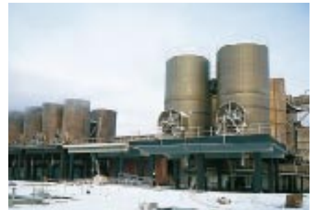
Kokkolan sinkkitehtaan laajennus on edennyt suunnitelmien mukaisesti sinkkituotannon jatkuessa koko ajan normaalitasolla. Kuvassa uudet jäähdytyskolonnit.
