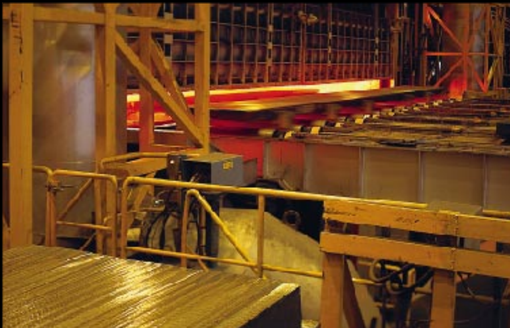
Terässulatoilta tulevien aihoiden lämpötilaa nostetaan kuumavalssaamalla askelpalkkiuunissa, jonka kapasiteetti on 120 tonnia tunnissa.
