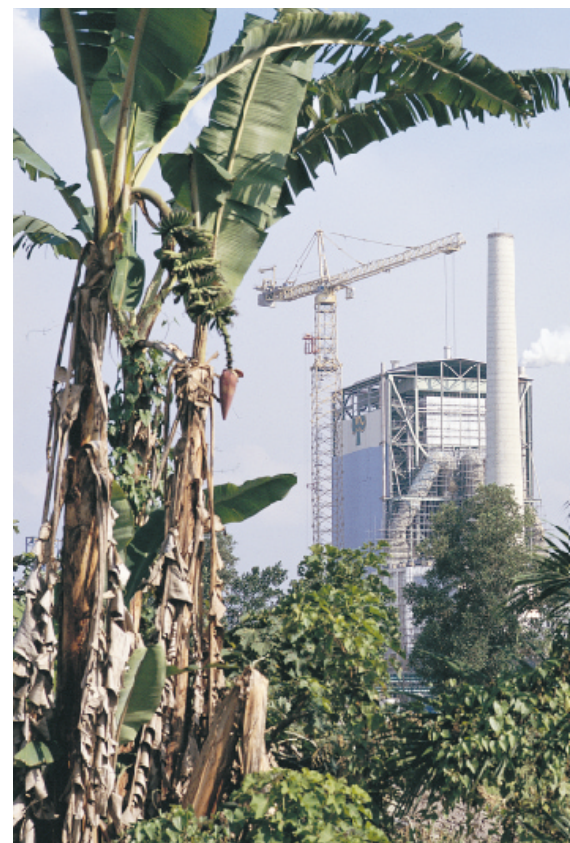
Sunilan uusi valkaisimo valmistuu heinäkuussa 1998. Valkaisimo perustuu ECF-tekniikkaan, jossa valkaisukemikaaleina käytetään klooridioksidin lisäksi runsaasti happea ja peroksidia. Laitoksen joustavuus mahdollistaa erilaisten sellulaatujen tekemisen jopa samanaikaisesti. PI toimii laitos- ja detaljisuunnittelijana ja vastaa sähkö- ja automaatiosuunnittelusta. Suunnitelmat tehdään kolmiulotteisena ja uusinta tiedonsiirtotekniikkaa hyödyntäen.
