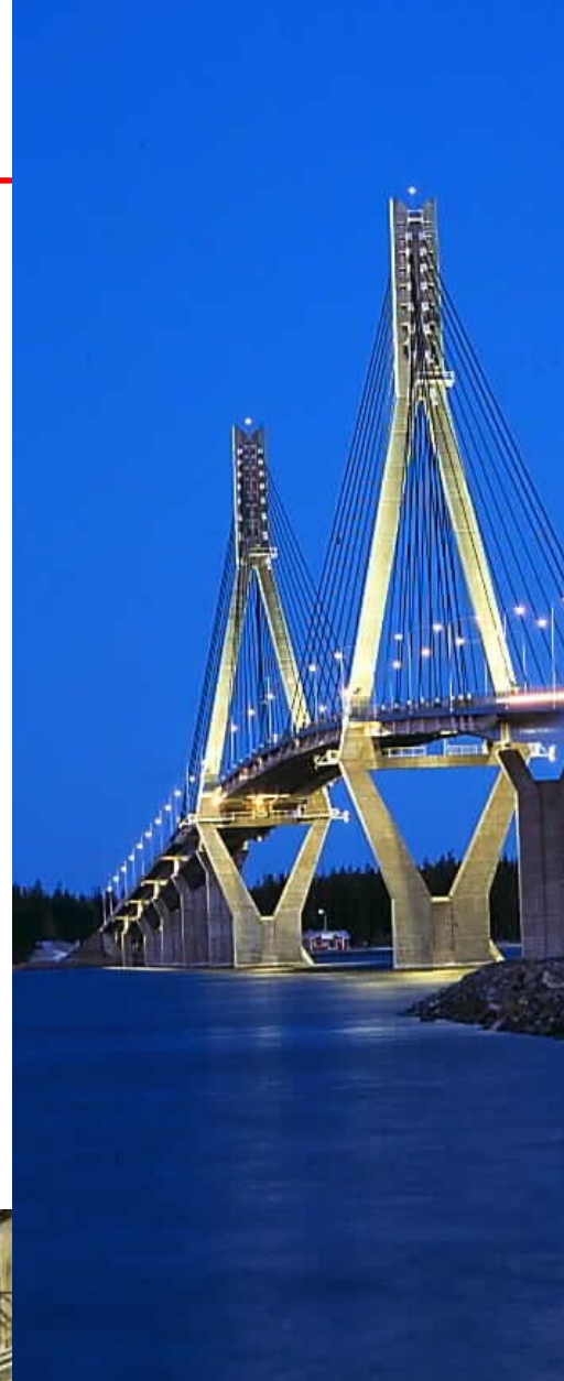
Syksyllä valmistunut Raippaluodon silta on Suomen pisin. Sillan rakenteisiin käytettiin yli 3000 tonnia Rautaruukin hienoraeterästä.
