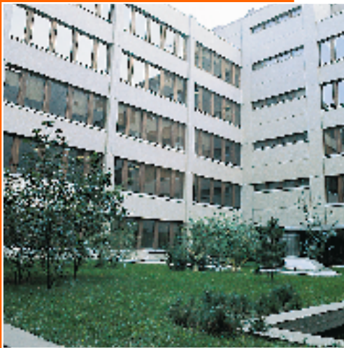
Vuoden alkupuoliskolla toteutettiin pääkonttori-rakennuksen uudistamistyö.
