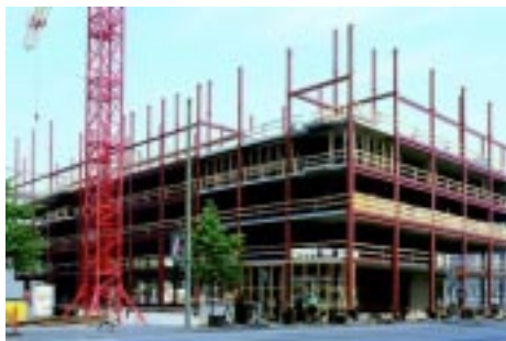
Teräsrungon etuihin kuuluu mm. nopea asennusaika. Kiinteistö Oy Itämerenkatu 3:n toimisto- ja liiketalon teräsrunko Helsingin Ruoholahdessa.
