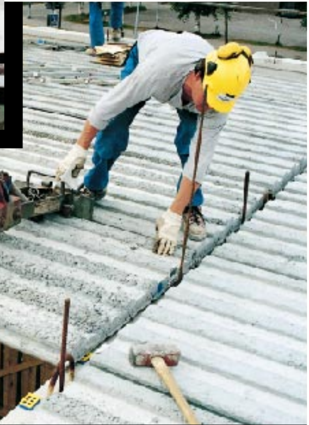
Ensimmäiset uudet kuorilaatat asennettiin Parma Betonilan työmaalle Vantaalla.
