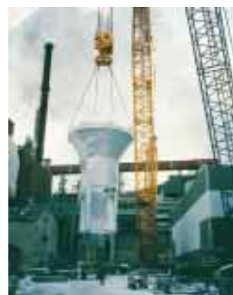
Reaktorin nosto MoDo:n Husumin mäntyöljytehtaalla
