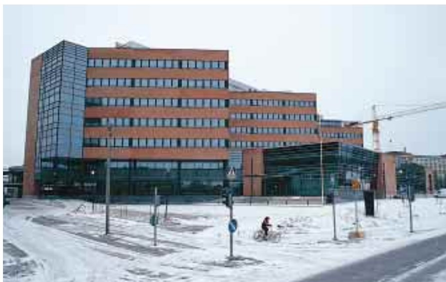
Nokia Oyj:lle rakennettiin toimistorakennus Tampereella.
