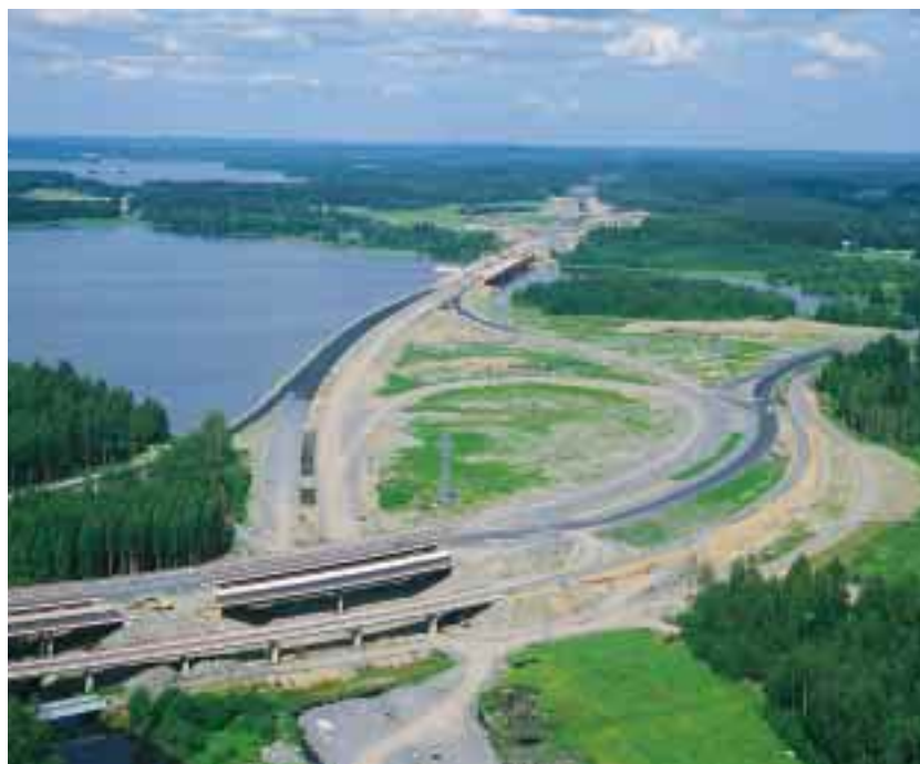
Valtatie 3:lla valmistui Konhon eritasoliittymä Toijalassa.
