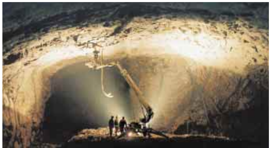
Helsingin ydinkeskustaan louhittiin Kluuvien 720 autopaikan pysäköintilaitos.
