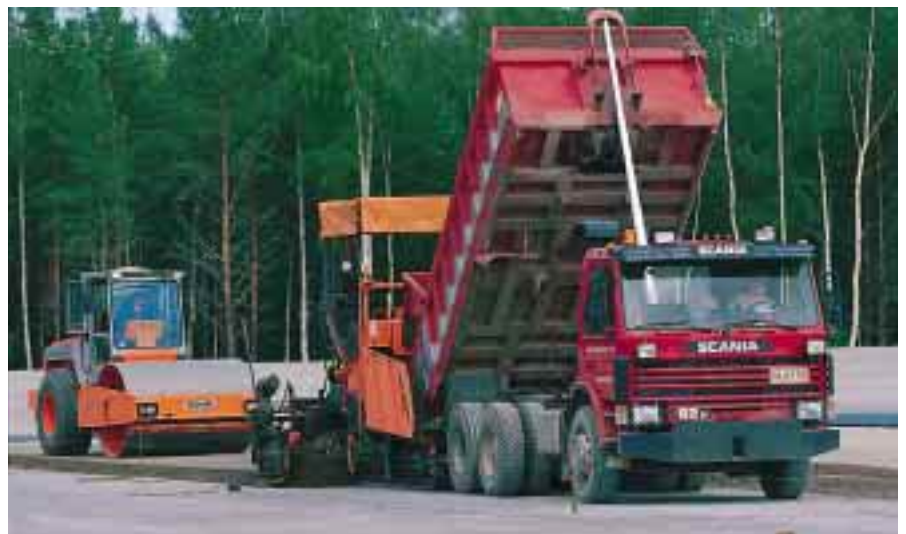
Oulun Ruskon kaatopaikan laajennus toteutettiin vesitiiviillä asfalttirakenteella. Mineraalieristystyö käynnissä.
