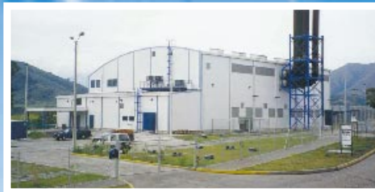
Wärtsilä NSD:n toimittama 25 MW:n Pure Energy kaasuvoimala Cementos Diamante Ibaguéssa Kolumbiassa.
