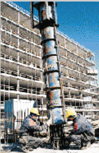
Työmaan yleinen järjestys takaa työturvallisuuden. Ja tiedon kulku töiden sujuvuuden.
