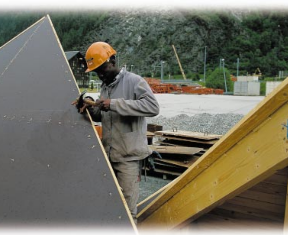
Schauman Woodin Wisa-Form -vaneria käytettiin betonointilevynä maasillan rakennustyömaalla Ranskassa.
