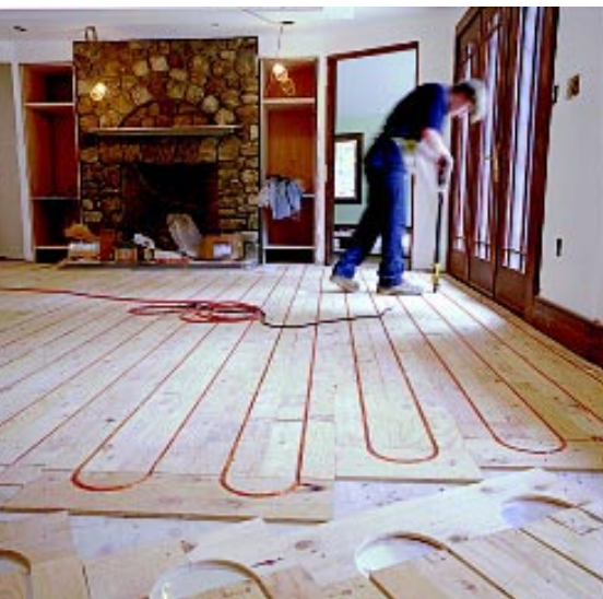
Stadler-menetelmällä toteutettu lattialämmityshanke soveltuu amerikkalaiseen puurakennusperinteeseen.
