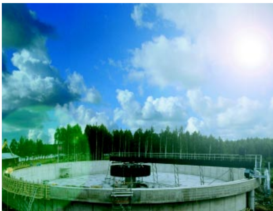
YIT:ssä on kehitetty uutta erityistekniikkaa metsäteollisuuden jätevesien puhdistamiseen. Aktiivilietepuhdistamon energiankulutus on alle puolet perinteisen jätevesilaitoksen kulutuksesta. Täyden mittakaavan laitos on käynnistetty Enso Publication Papersin Anjalan tehtailla.
