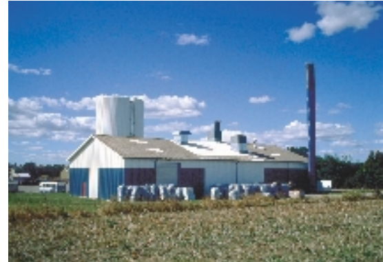
Gas power plant in Præstø Denmark generates electricity and heat.
