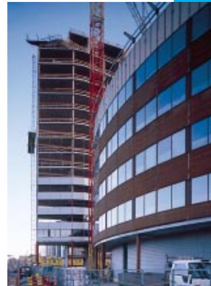
Kiinteistö Oy Itämerentori in the Ruoholahti area of Helsinki.
