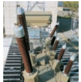
Fingrid Oy osallistui tiiviisti uuden FINGRID 2000 -suurmuuntajamallin suunnitteluun.
