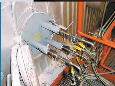
Mittaussondeja CFB-kattilassa.
