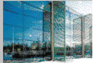
Smarthouse, Technopolis Oulu, päärakennus
