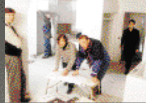
Asuntotiimi työmaalla, Espoo
