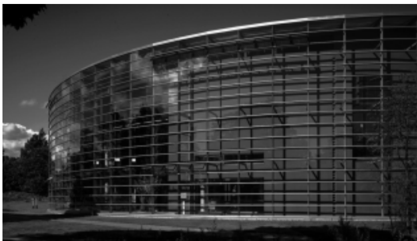
Nordic Aluminiumin alumiiniprofiileja Viikin tiedepuiston Infokeskuksen julkisivussa.
