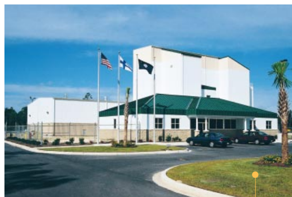
Charlestonin stanoliesteritehdas valmistui keväällä 1999.
