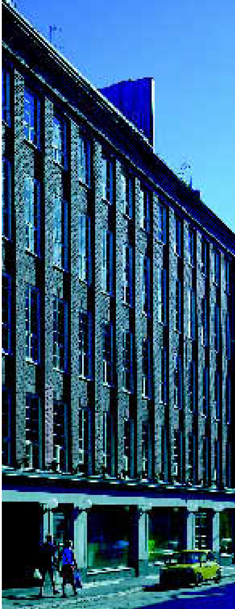
Toimistotalon Kalevankatu 30 on piirtänyt vuonna 1928 arkkitehti Ole Gripenberg. Rakennus on perusparannettu vuonna 1998.
