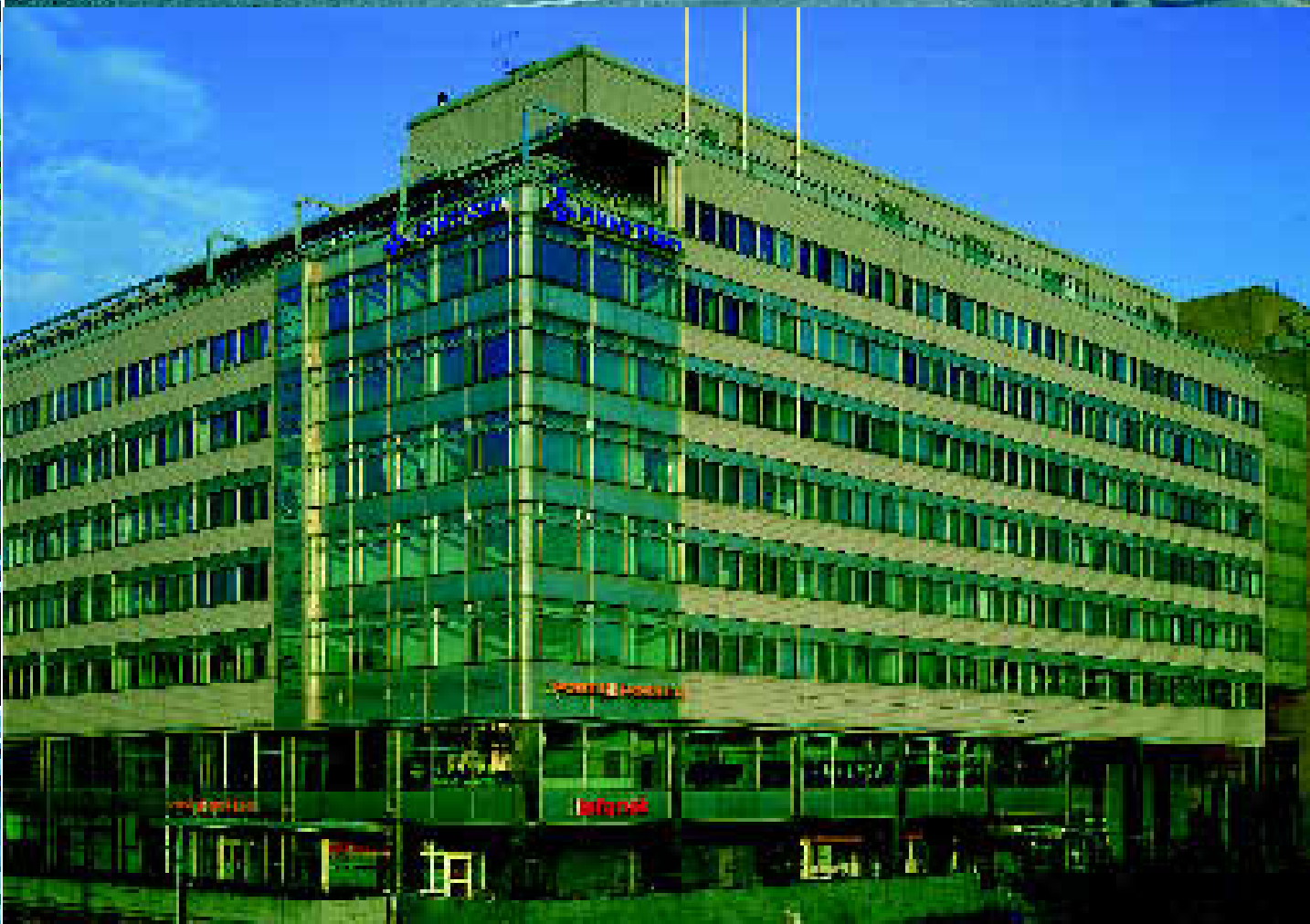
Ylhäällä Leonia-pankilta kesäkuussa ostettu, pääosin 1960-luvulla rakennettu Makkaratalo-kompleksi, jonka imagon kohennus ja kehittäminen kauppakeskukseksi on suunnitelmassa. Alhaalla yli 15 000 m 2 :n toimistotalo Pasilan aseman vieressä Ratapihantie 11, joka on yksi Spondan kolmesta kantakaupungin reuna-alueiden kiinteistöistä.
