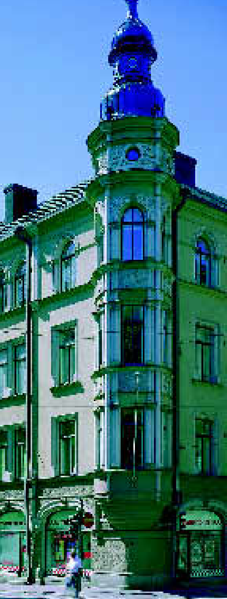
Dianankulma, Yrjönkatu 16, on arkkitehtitoimisto Grahn-Hedman-Wasastjernan vuonna 1898 suunnittelema uusrenessanssityylinen rakennus, joka peruskorjattiin ja entisöitiin vuosina 1991–1992.
