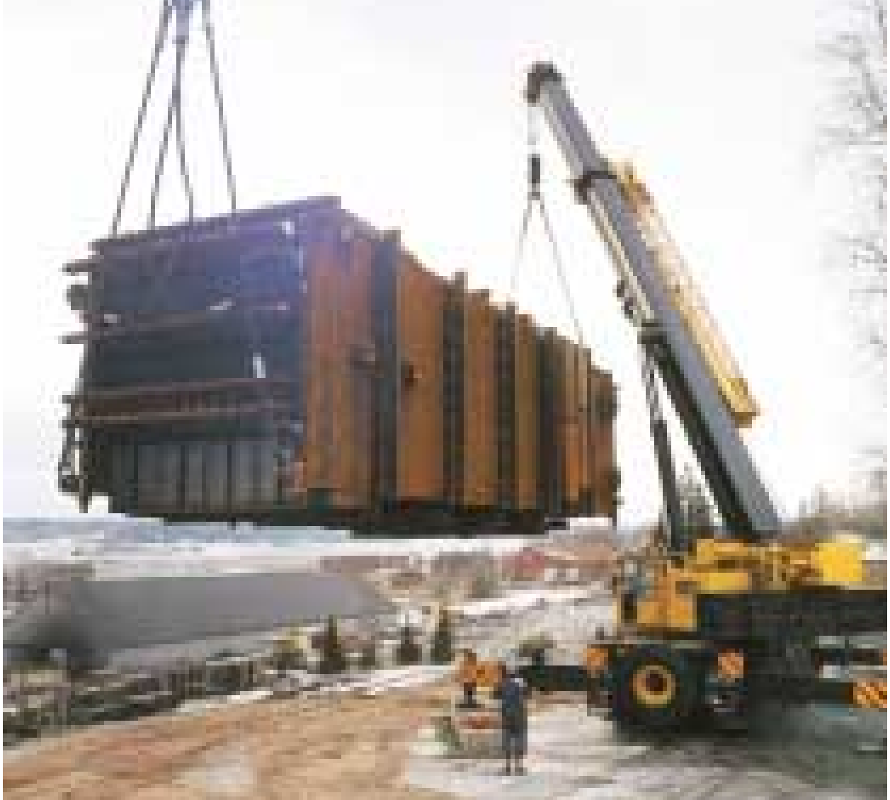
Vapon yhdessä Sucros Oy:n ja ABB Service Oy:n kanssa perustama Voimavasu Oy aloitti 33 MW:n voimalaitoksen rakentamisen Saloon vuonna 1999. Voimalaitoksen 85 tonnin painoista kattilan tulipesää asennettiin joulukuussa.
