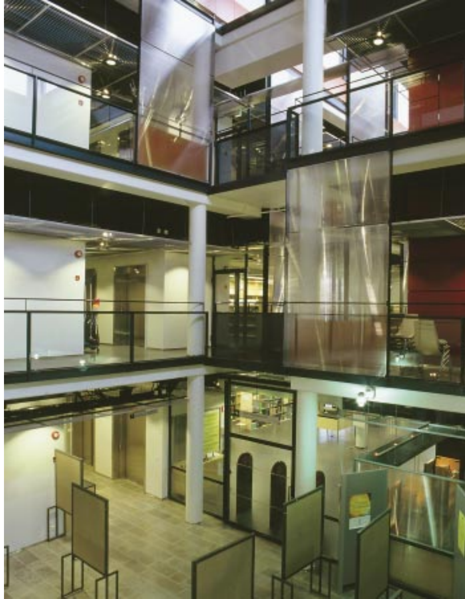
Helsingin yliopiston Viikin kampukselle valmistui kesällä 1999 Infokeskus, jossa lvi-työt toteutettiin design & build -periaatteella.
