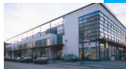
Ruoholahdessa valmistui metroaseman laajennusosa, joka tuli pääosin Teknisten Liiton ja Helsingin seurakuntayhtymän omistukseen ja käyttöön.
