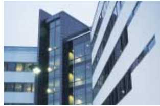
Takomo, Nokia office, Helsinki
