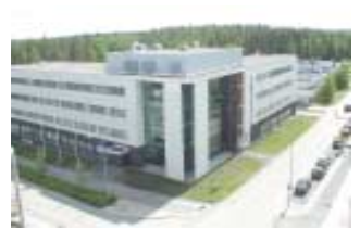
Ohjelmakaari I, office building, Jyväskylä
