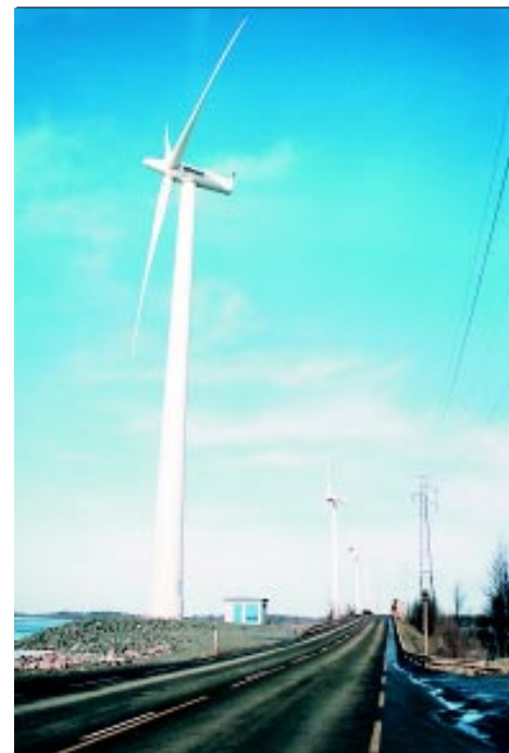
Hyötytuuli Oy's wind farm in Meri-Pori, surface treatment works.
