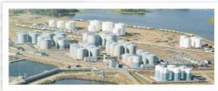
Transkemillä on Kotkan Mussalon satamassa 30 000 m 3 uutta säiliötilaa.
