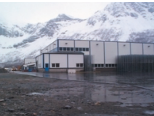
Prepan Norge AS Färsearille rakentaman Klosterboer Terminalin kokonaisrakennusala on 3700 m 2 , josta kylmävarastotilaa on 2600 m 2 .
