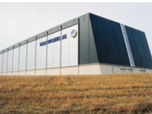
Prepan Danmark AS:n rakentamassa Vejle Kole og Frysehusissa käytettiin 13.000 m 2 PUR-eristeisiä elementtejä.
