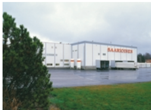
Sabroe Finland Oy:n Ruoka-Saarioisten Sahalahteen tehtaalte rakentaman lämpöpumpun ansiosta tehdas pystyy vähentämään ympäristökuormitustaan neljänneksellä.
