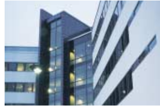
Takomo, Nokian toimitalo, Helsinki
