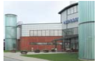
Aspocomp, tehdaslaajennus, Salo
