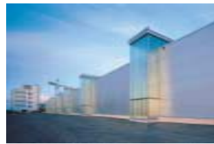
PKC, tuotanto- ja toimistorakennus, Oulu
